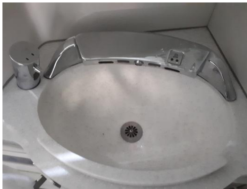
일체형 수전설비 설치
